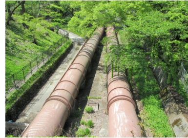
水の一部は水圧鉄管を通り発電所へ
